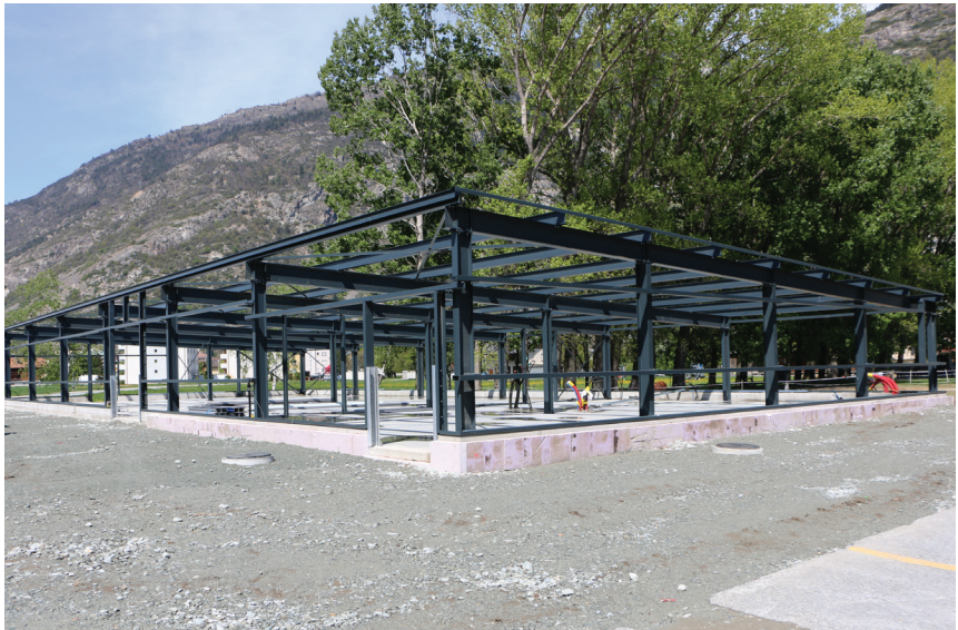
Die Einstellhalle Tandem 91 im Rohbau.
